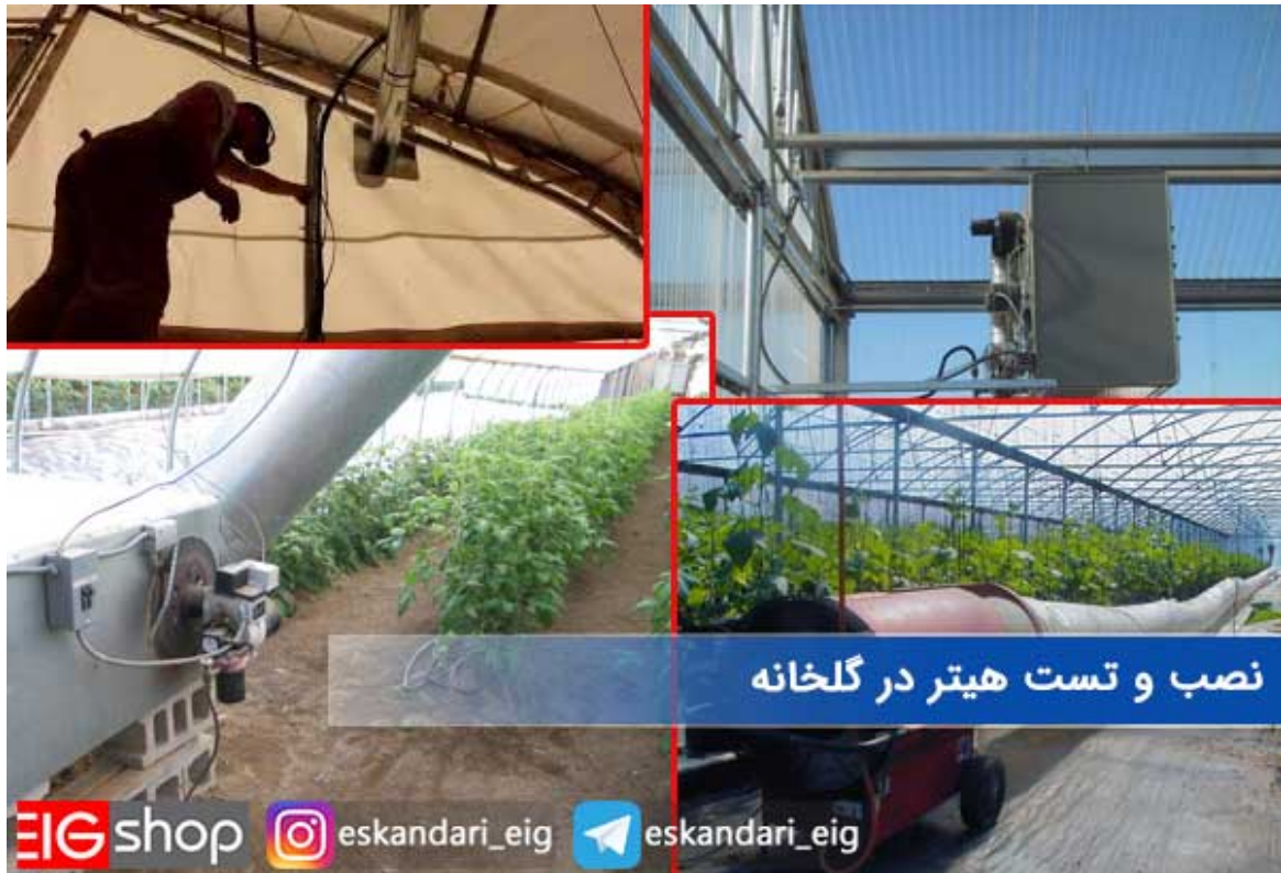
نصب و تست هیتر در گلخانه
